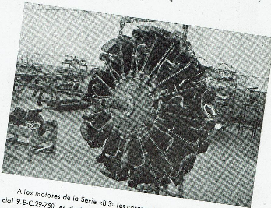
A los motores de la Serie «B 3» les corresponde una denominación oficial 9.E-C.29-750, es decir, que se trata de un motor de nueve cilindros en estrella, con compresor que restablece la potencia a 2900 m de altura y potencia de 750 CV.
